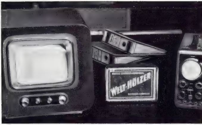
Bild 4. Der Miniatur-Fernsehempfänger im Betrieb, daneben das Modell des Breitband-Oszillografen
